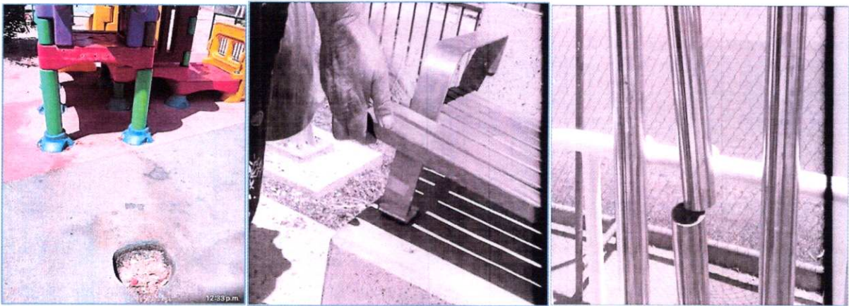
Vandalización en obra de Guanaco y deterioro de equipamientos y juegos en Centro Barrial
