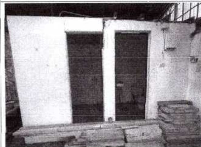
Acceso a recintos de baño, concordantes con planimetría.
