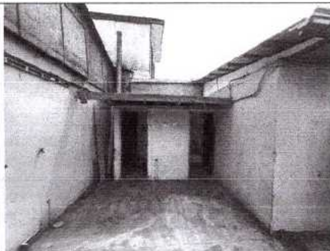
Detalle edificaciones zona delantera del predio, concordante con planimetría.
