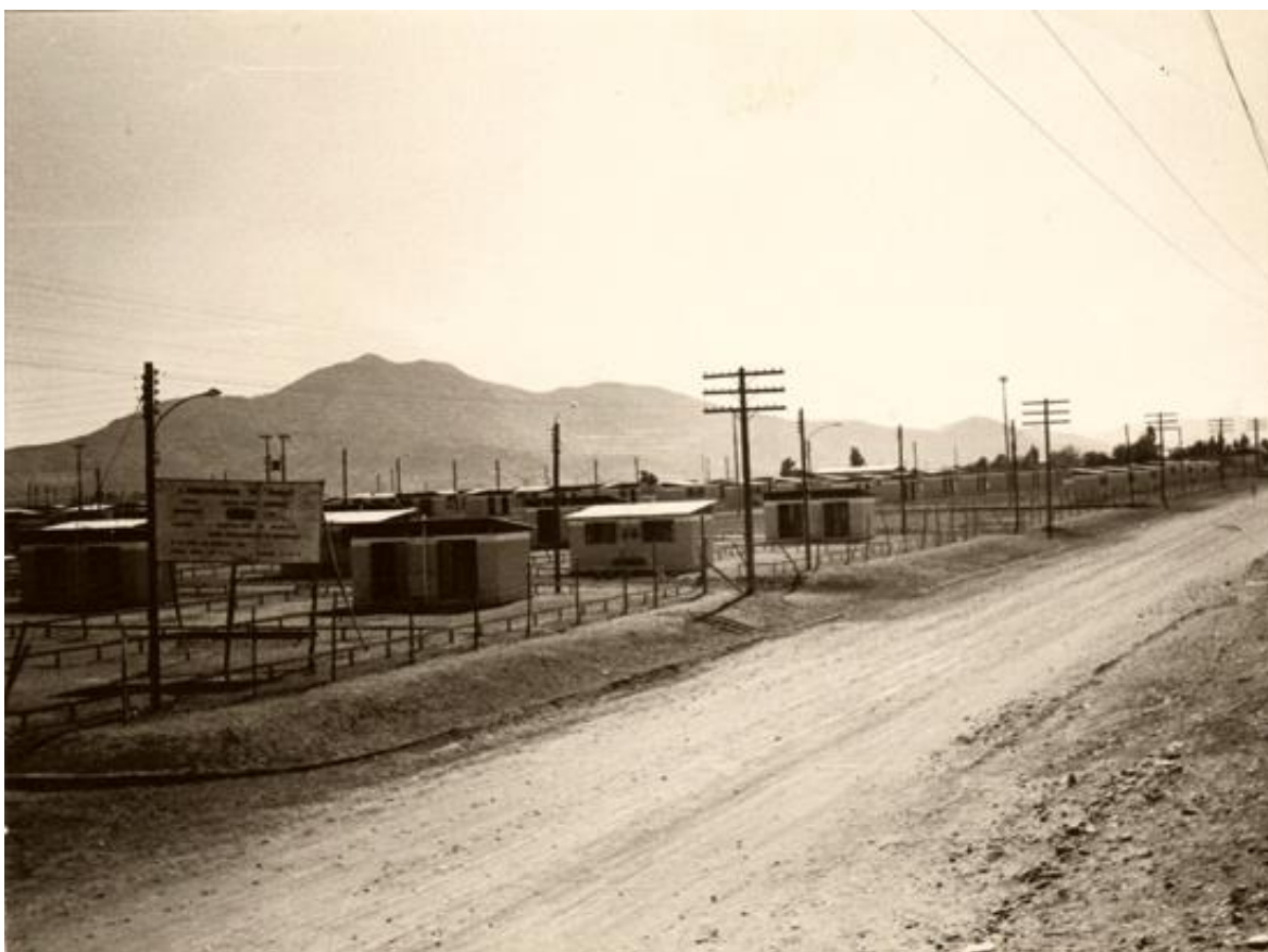
Panorámica de las casetas sanitarias y la división de sitios en la avenida La Paz de la población Media Hacienda. Año 1982 - Siglo XXI
