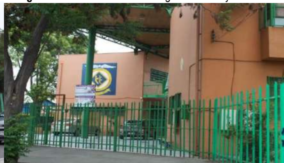
Fotografía N°7: Escuela Aviador Dagoberto Godoy
