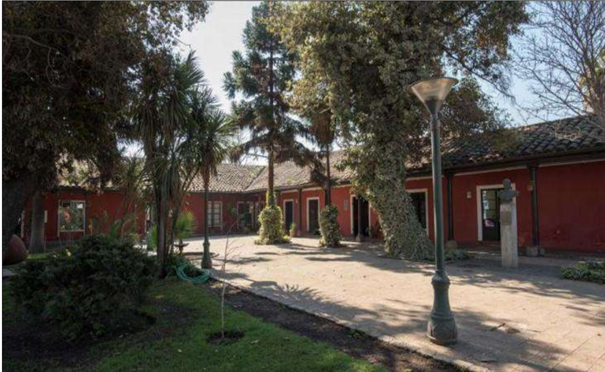
Fotografía N°13: Casa Consistorial, Municipalidad de Conchalí, Ex Casa Patronal Chacra Lo Negrete
