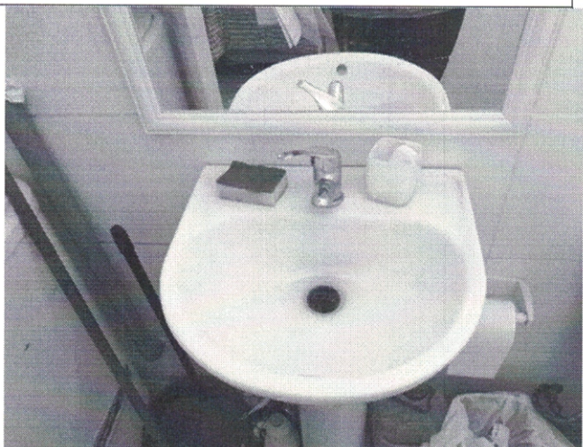
Lavamanos Baño Segundo Nivel
