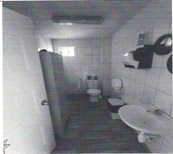
Baño de personas con capacidad disminuidas de local comercial
