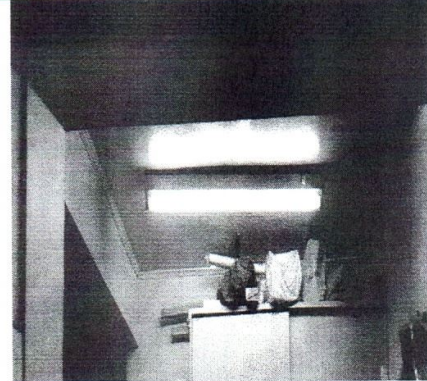
Extractor de Aire N°3 no existe en edificación
