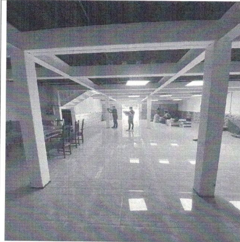
7.- imagen desde "Bodega", sin tabique divisorio.
